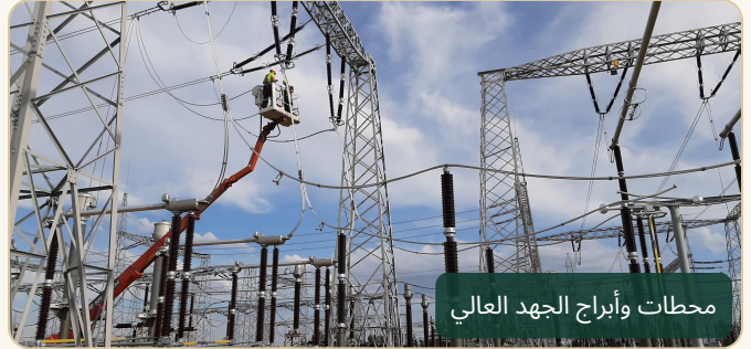
صيانة المحولات الكهربائية
